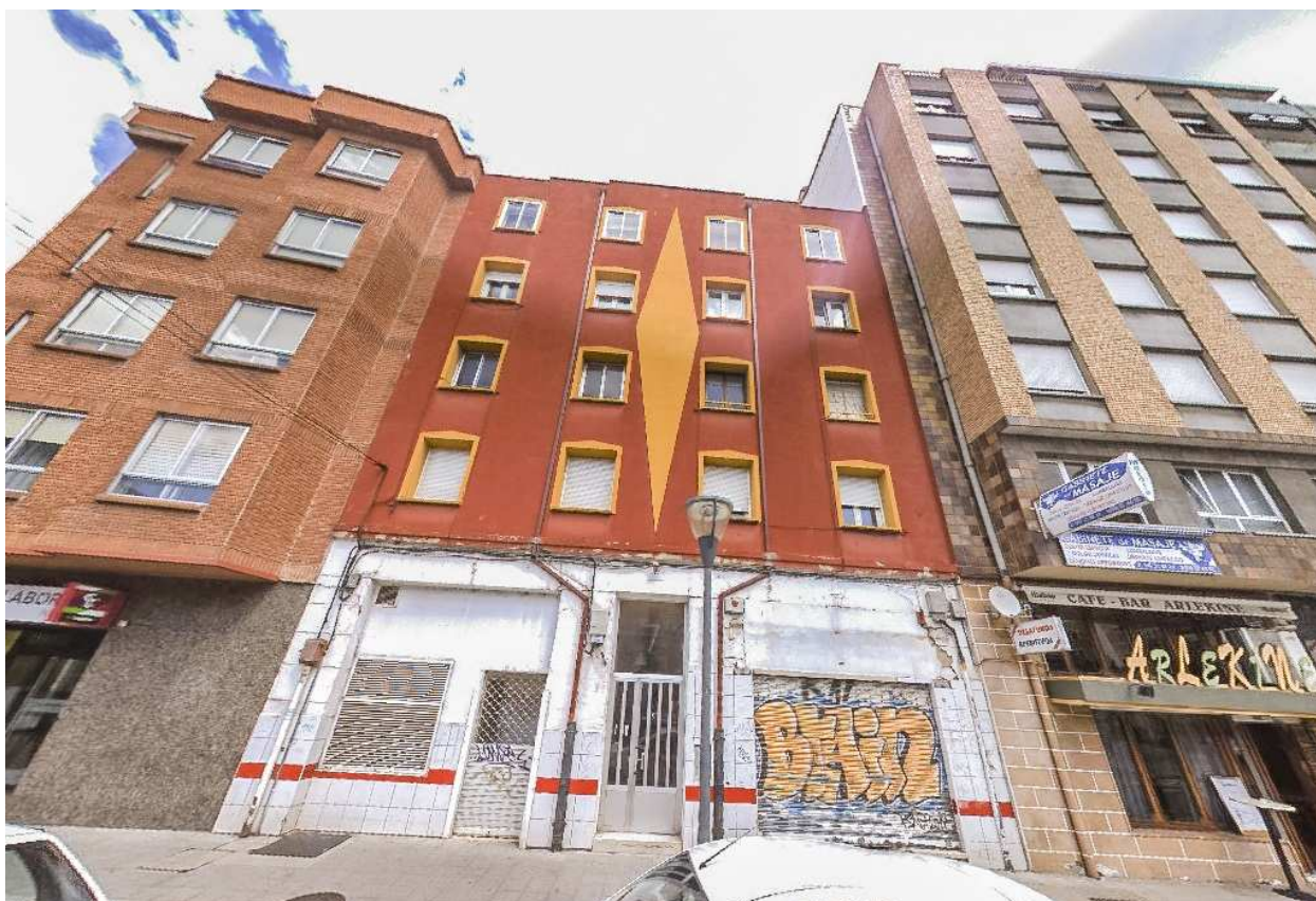
Imagen edificación frente de fachada a calle Clunia.
